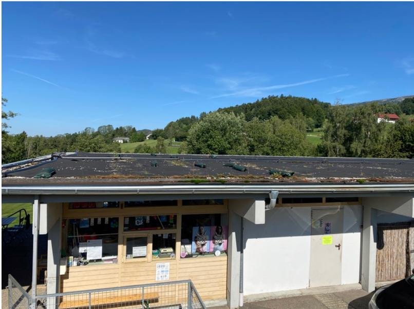
Die Überdachung des Aufenthaltsbereiches des Buffets wurde an die bestehende Dachkonstruktion angebaut, die Sparren sind jedoch statisch stark unterdimensioniert, darum muss das Dach in den Wintermonaten untergestellt werden, um der Schneelast standhalten zu können.
