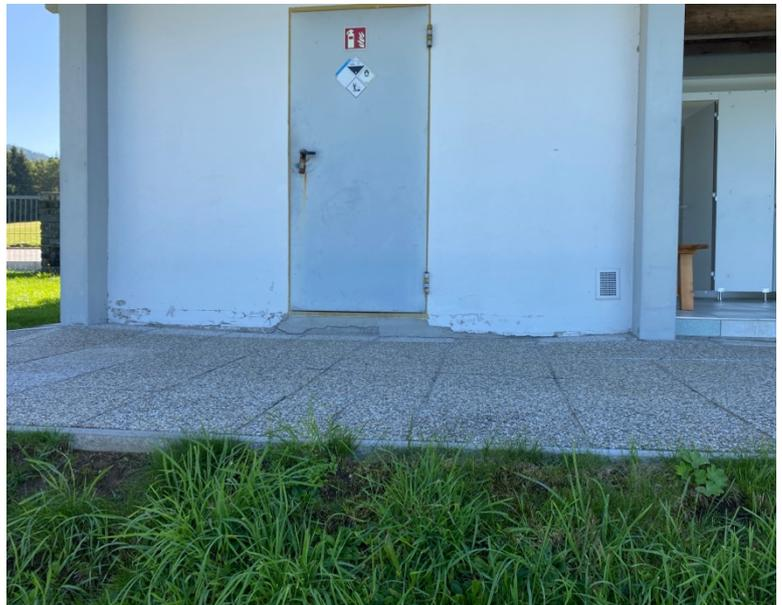
Es gibt einige Fehlstellen im Bereich der Konstruktion sowie Feuchte- u. Frostschäden im Bereich des Sockels. Hier sind Sanierungsmaßnahmen notwendig, um einen langfristigen Bestand der Gebäudestruktur zu erhalten.
